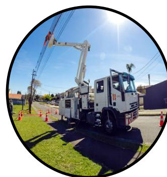
Obras via concessionárias de energia elétrica
