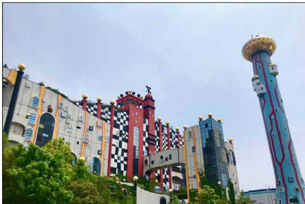
FIGURA 1 - USINA DE INCINERAÇÃO MAISHIMA, LOCALIZADA EM OSAKA
